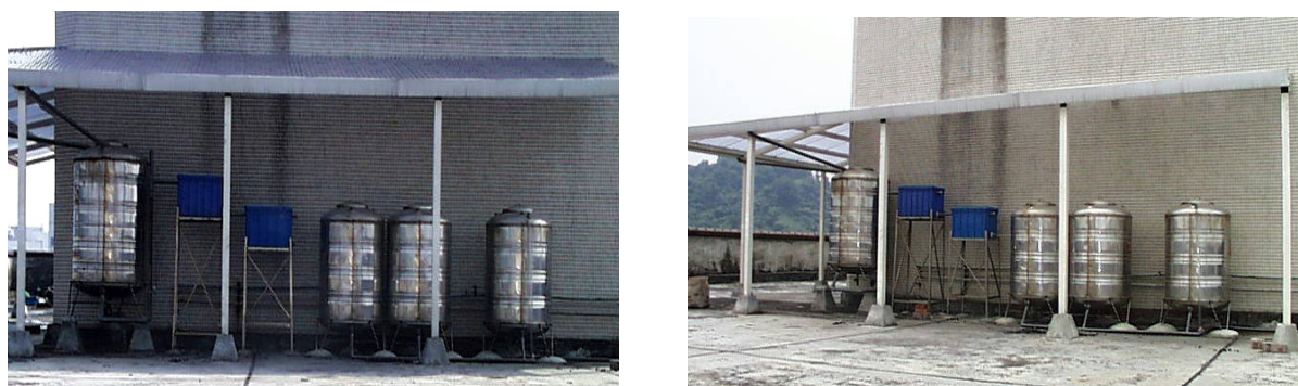
圖 5 雨水利用系統實驗裝置及集雨區域之現場照片
